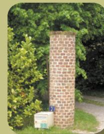
La variété des couleurs provient de la qualité des argiles, plus ou moins calcaires ou plus ou moins ferrugineuses, de l'appauvrissement en oxygène de l'atmosphère du four...
